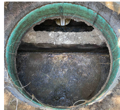
Niveau d'eau normal dans une fosse septique
